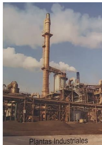
Exterior de Tanques de Acido Sulfúrico
